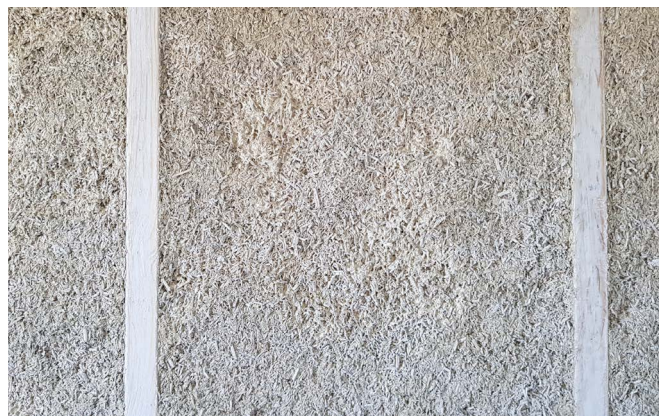
Pecquenchanvre, béton de chanvre projeté © Mission Bassin Minier
